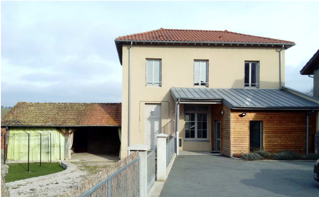
Salle de Mayol vue de la route (ancienne école de Mayol)
