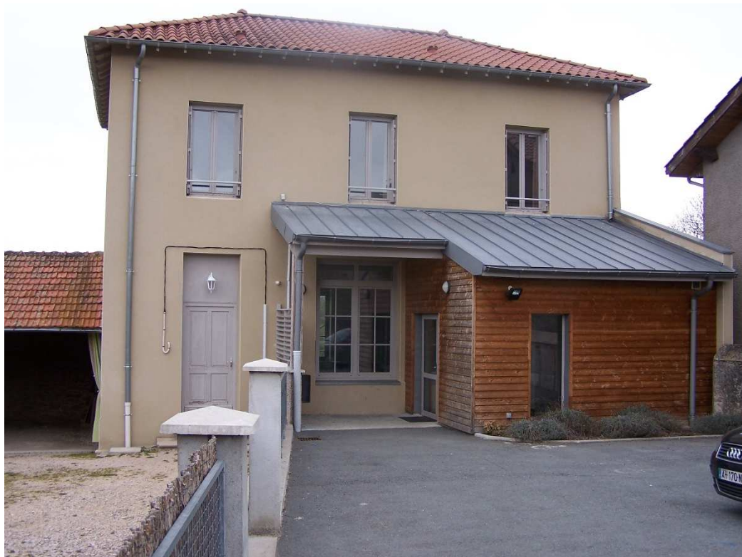
Salle de Mayol vue de la route (ancienne école de Mayol)
