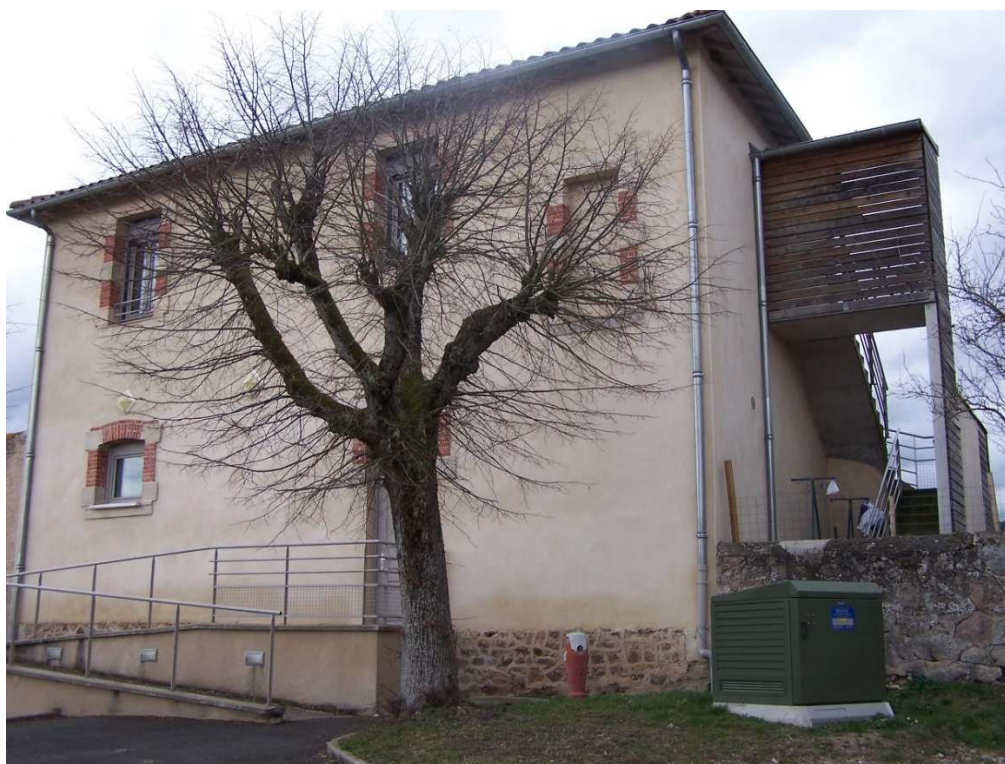
Entrée de la salle de Bruailles (ancienne école de Bruailles)
