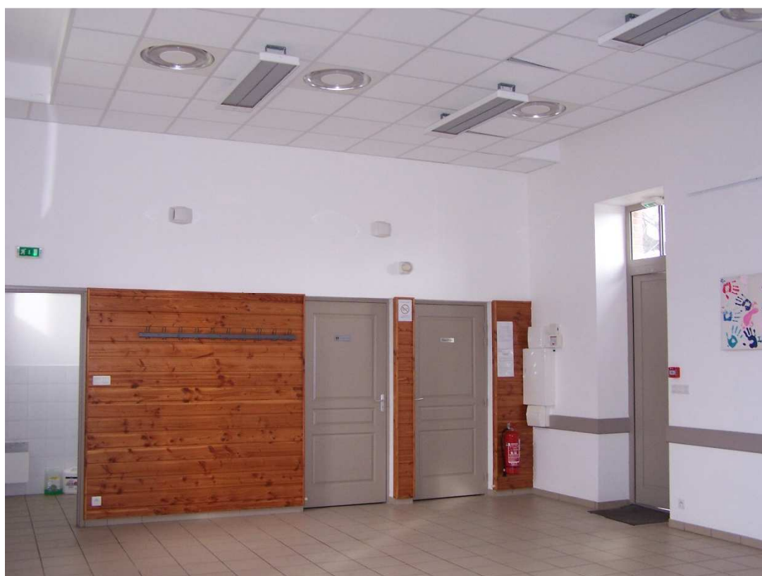
Intérieur de la salle de Bruailles (ancienne école de Bruailles)
