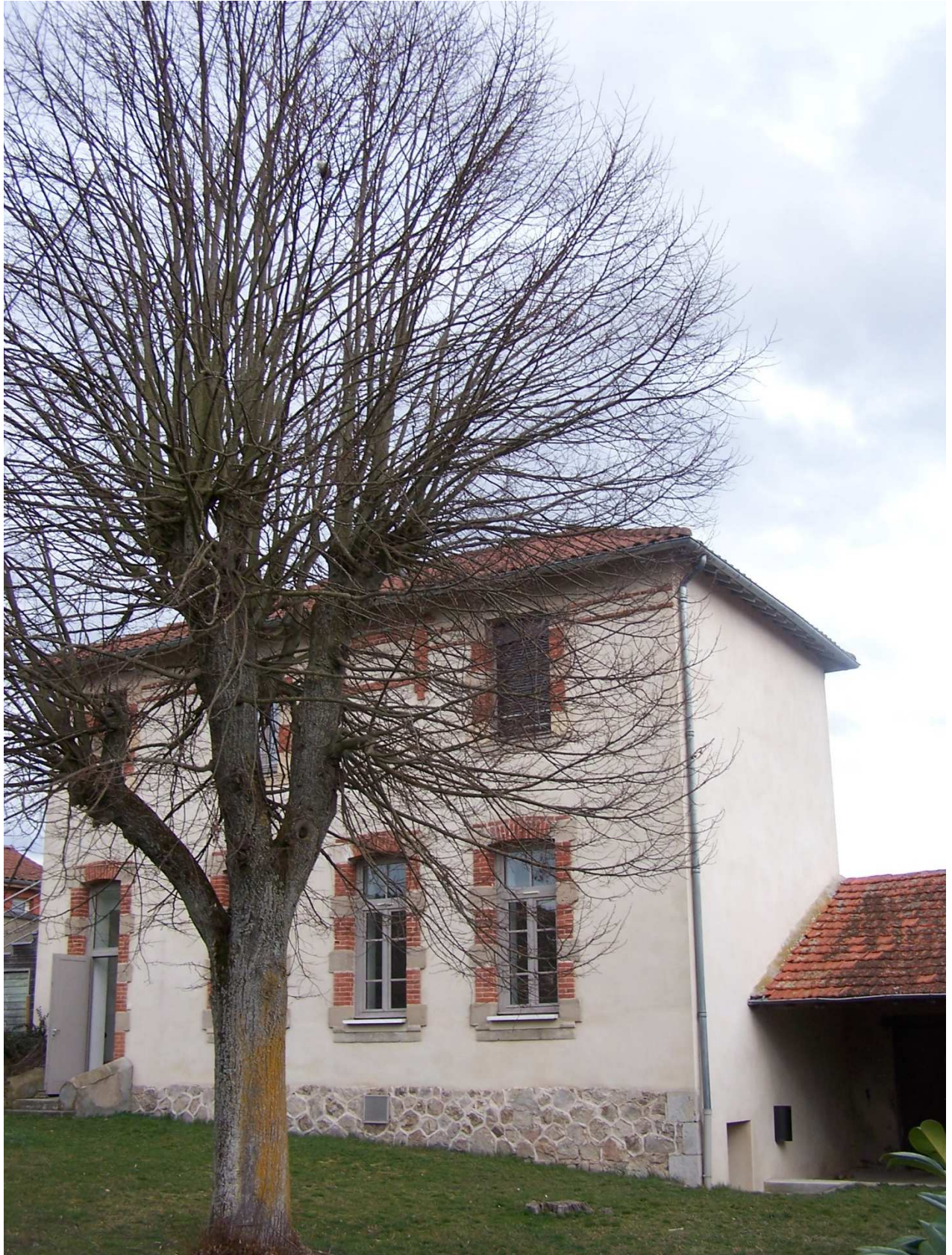
Salle de Bruailles vue de la cour (ancienne école de Bruailles)
